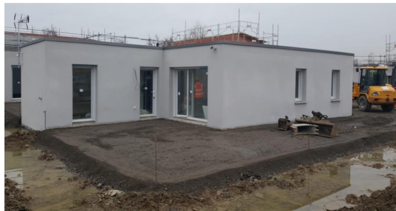
Logement témoin T3 site Rouillons décembre 2021
