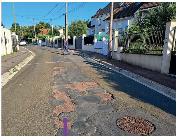
Projection d'enrobés au sol pour le comblement des nids de poules rue du Docteur Goldstein.
