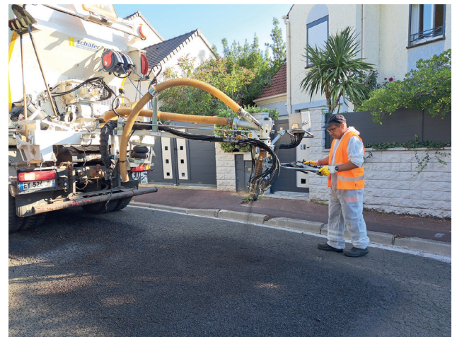
Projection d'enrobés au sol pour le comblement des nids de poules rue du Docteur Goldstein.
