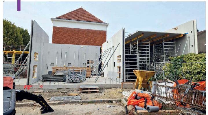
Pose des murs bétons préfabriqués en usine sur l'aile droite du bâtiment de l'école Poincaré.
