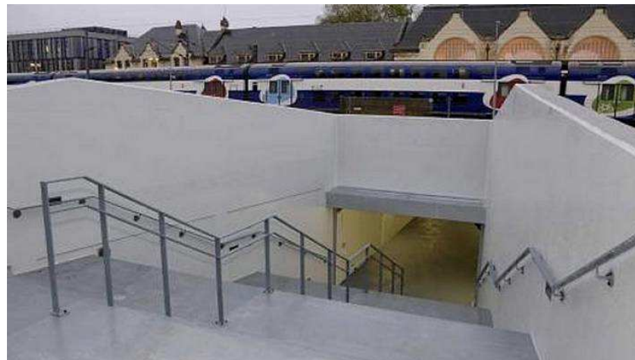
Exemple de passage souterrain
