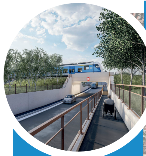
Un nouveau passage sous la voie ferrée permettant le passage des voitures, des bus et des camions (gabarit limité à 4m de haut).
