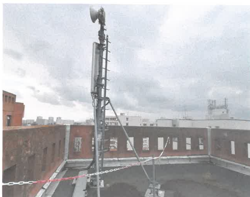
Vue de la terrasse S1 avant travaux
