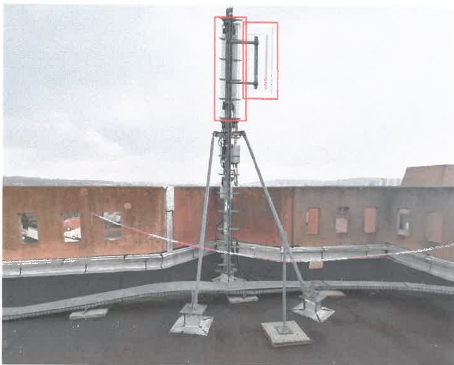
Vue de la terrasse S0 après travaux
