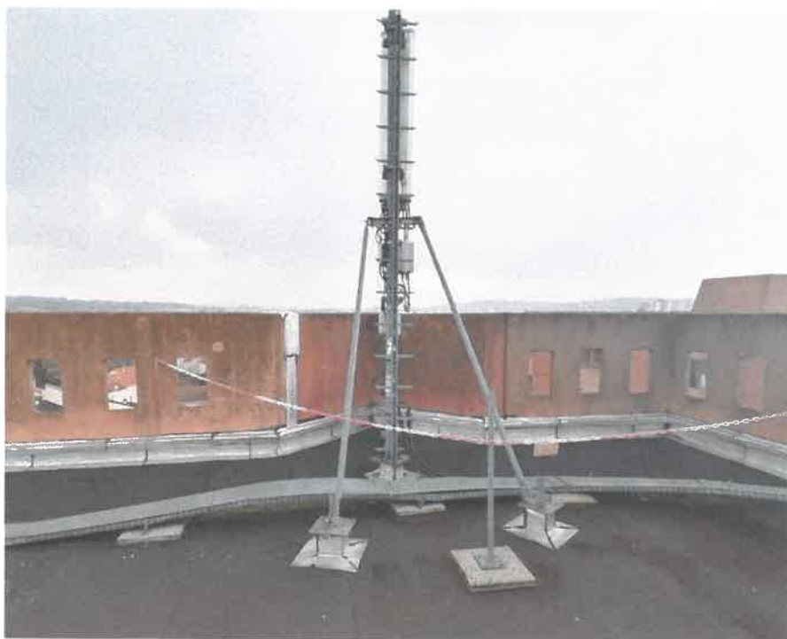
Vue de la terrasse S0 avant travaux
