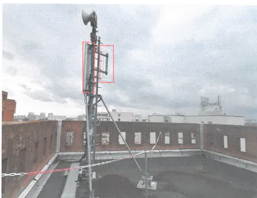
Vue de la terrasse S1 après travaux
