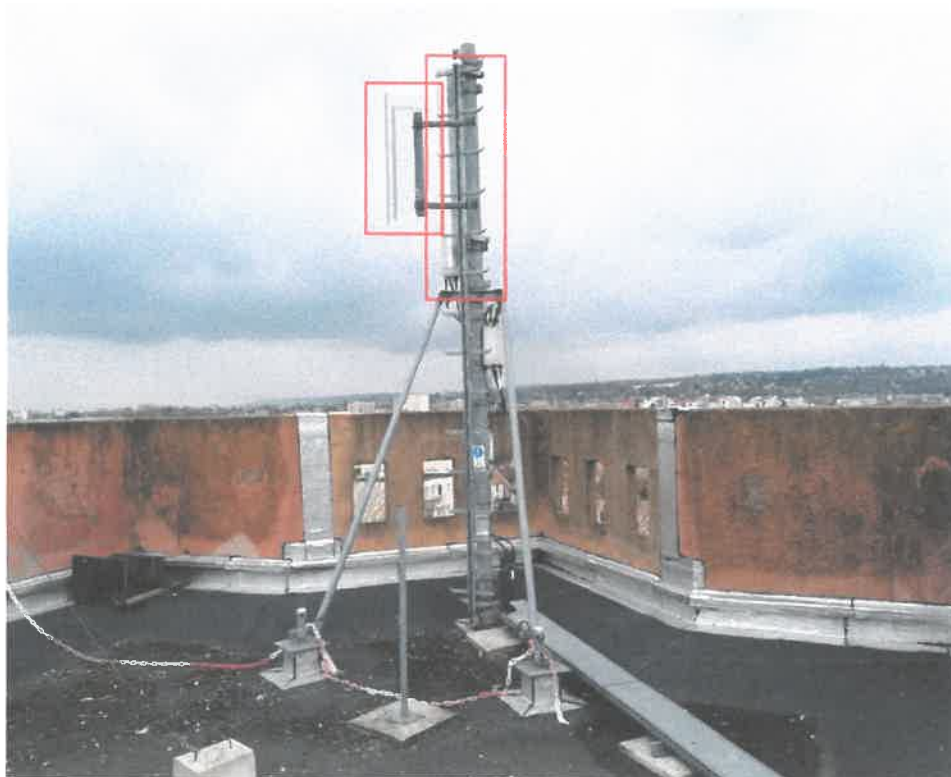
Vue de la terrasse S2 après travaux
