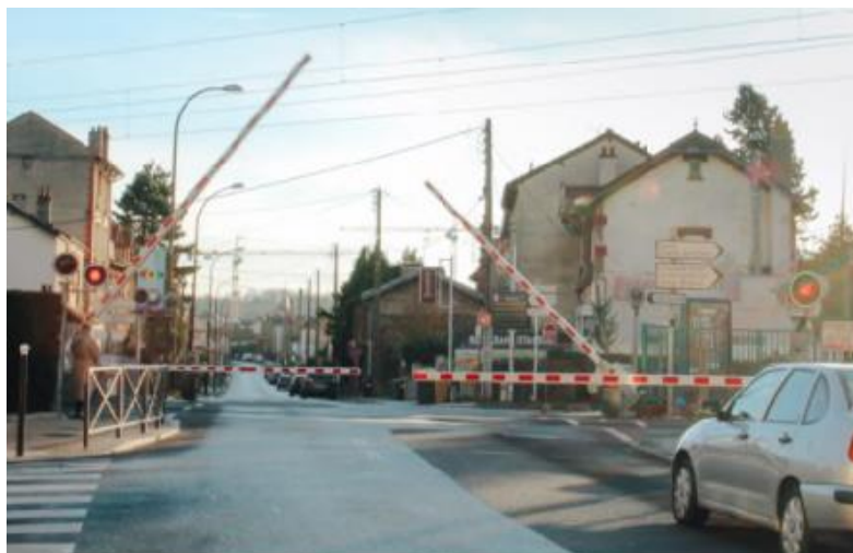
Passage à niveau n° 4 (SNCF Réseau)
